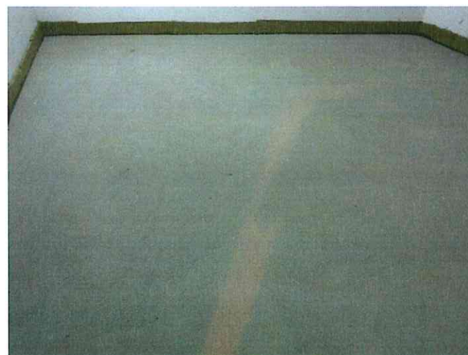
Abbildung A 2.3: Zementestrich (Prüfsituation)
