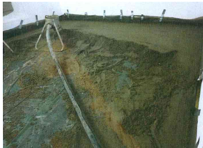
Abbildung A 2.2: Montagesituation mit Zementestrich
